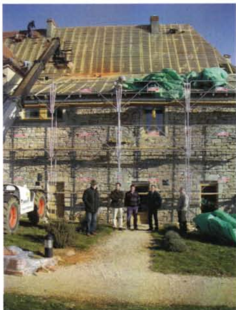
Les élus lors d'une réunion de chantier
